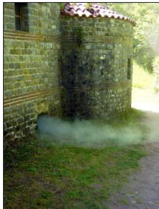
Fig. 4. Evacuation des fumées.
